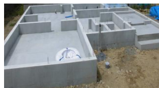
鉄筋コンクリートベタ基礎
